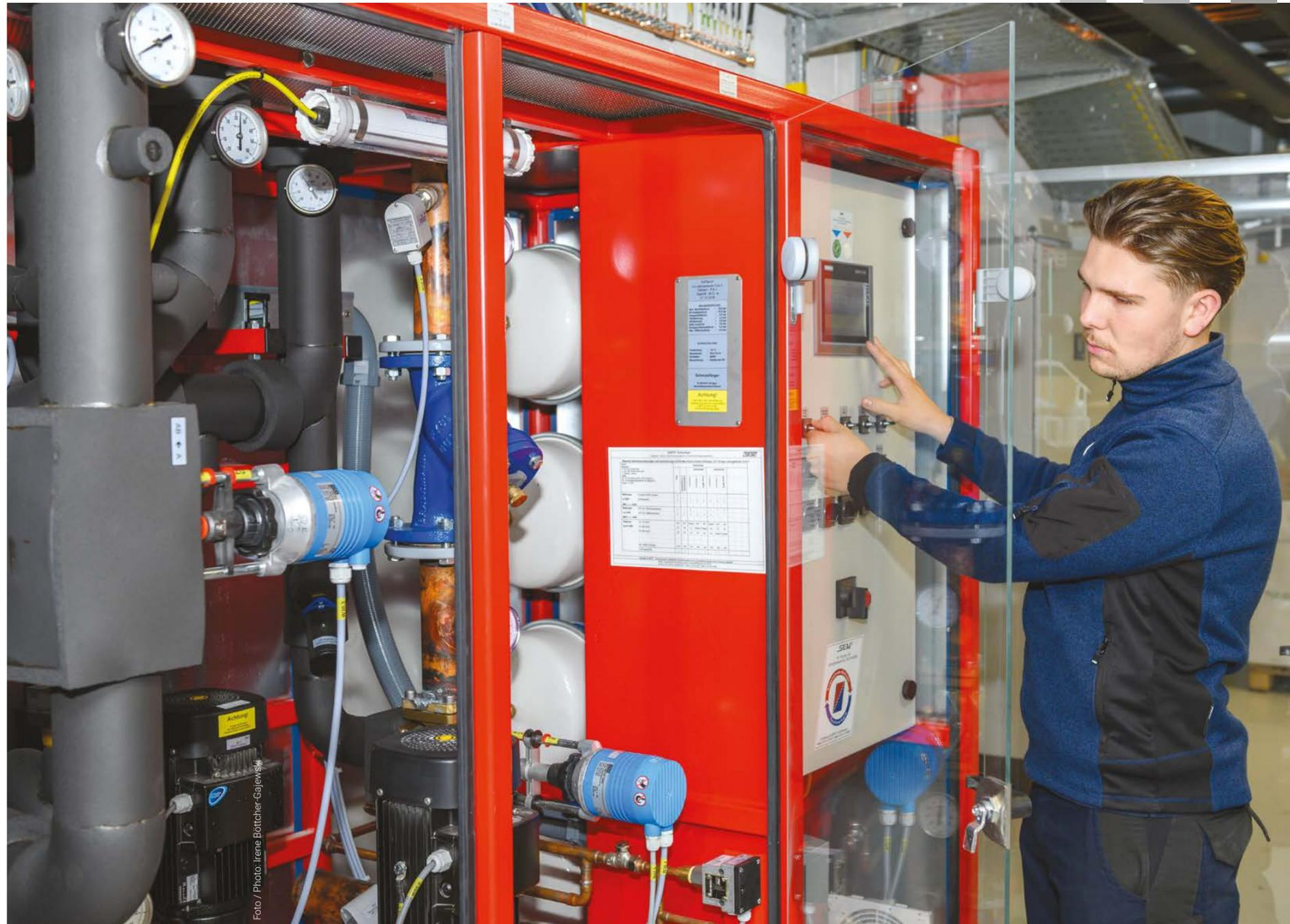
**Ausbilder Damian Fahlbusch (l.) wechselt zusammen mit Azubi Marvin Kopp ein Schrägsitzventil in der Warmwasserversorgung.** / *Instructor Damian Fahlbusch (l.) changes an angle seat valve in the hot water supply together with trainee Marvin Kopp.*
